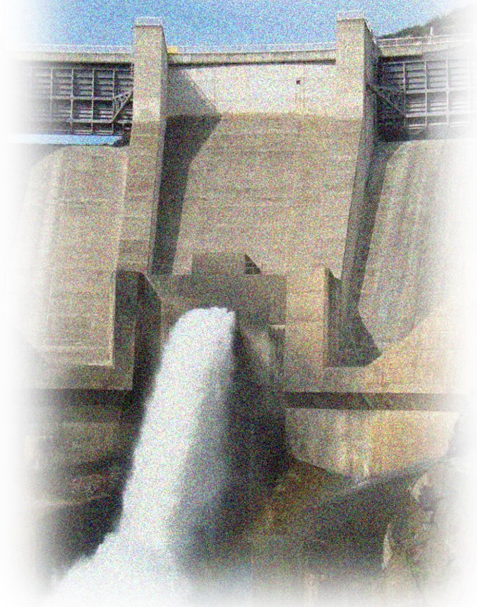
Barrage de Vinça
