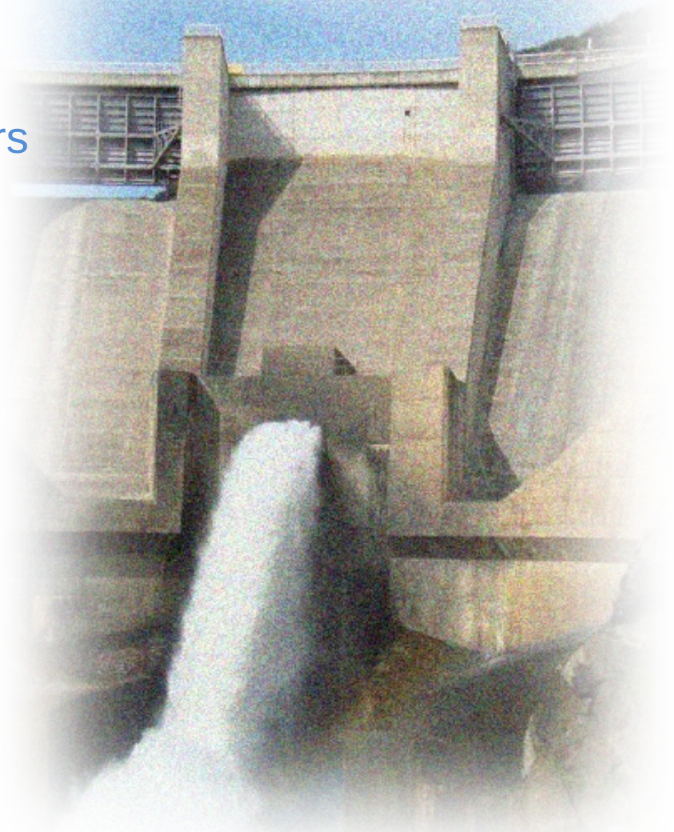
Barrage de Vinça
