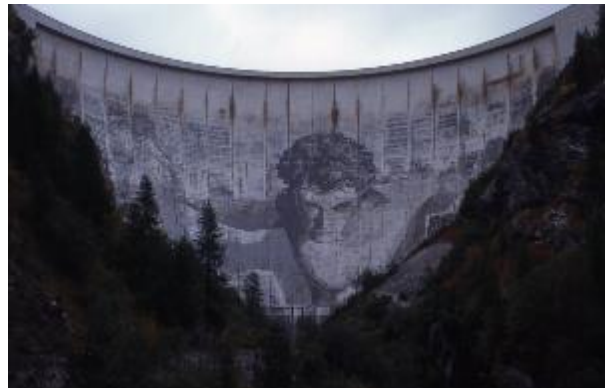
Plus haut barrage : Tignes (180 m)
