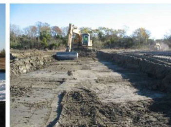
reprise du sol traité à la pelle sur la plate-forme de traitement
