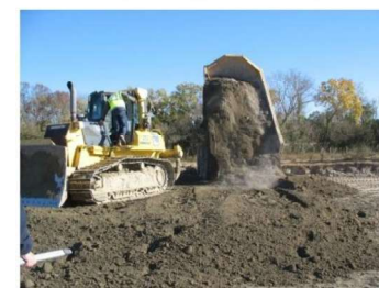
approvisionnement et régalaie du sol traité sur le fond de fouille du
