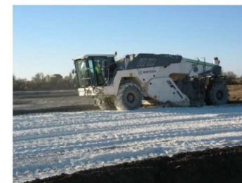
malaxage sur la plate-forme de traitement
