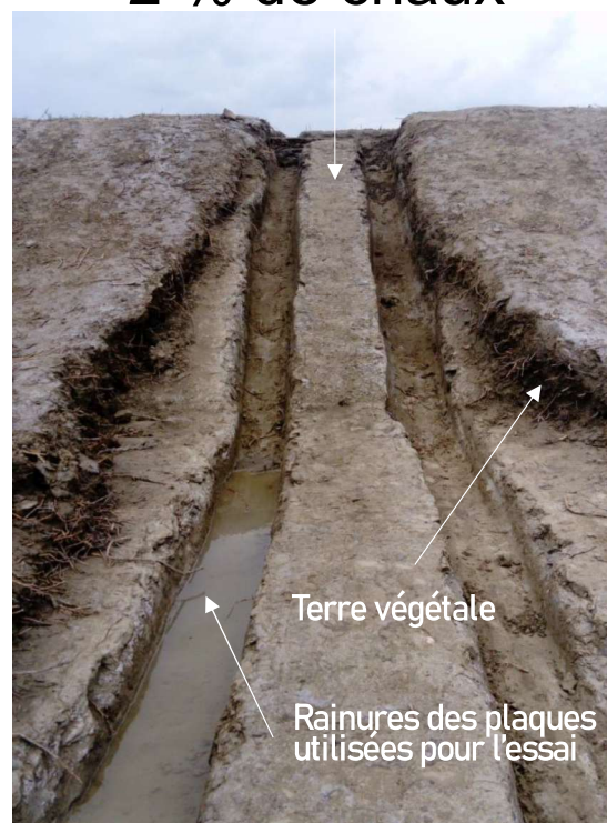
Sol traité à 2 % de chaux
