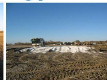
épandage de la chaux sur la plate-forme de traitement (600 m 2 )
