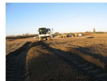
malaxage du sol naturel sur plate-forme avant traitement
