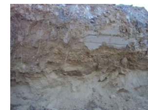
Suffusion d'une couche englobée de grave limoneuse/sableuse (ex. tout venant, couche de chaussée)
