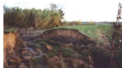
Suffusion d'une couche englobée de grave limoneuse/sableuse (ex. tout venant, couche de chaussée)
