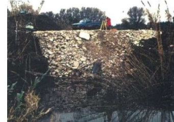
Erosion de contact le long d'une couche très perméable (ex. ancienne réparation d'urgence)
