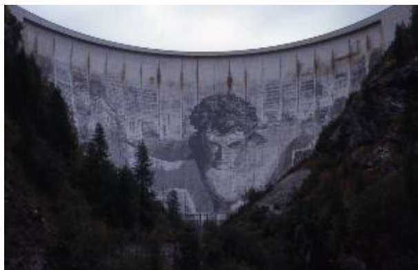
Plus haut barrage : Tignes (180 m)
