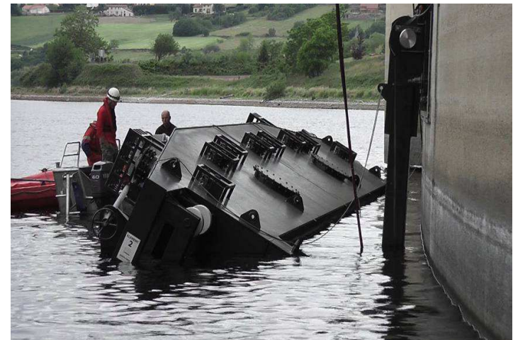
Mise en place batardeau flottant - Villerest
