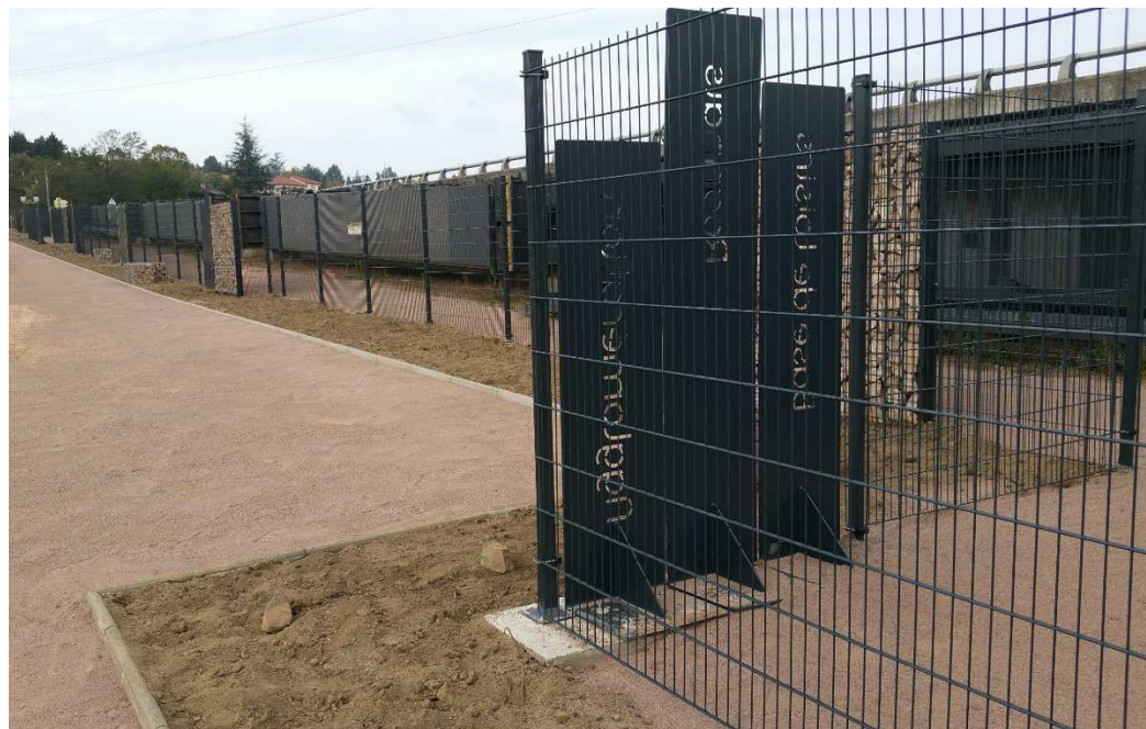
Zone de stockage du batardeau – © BRL Exploitation
