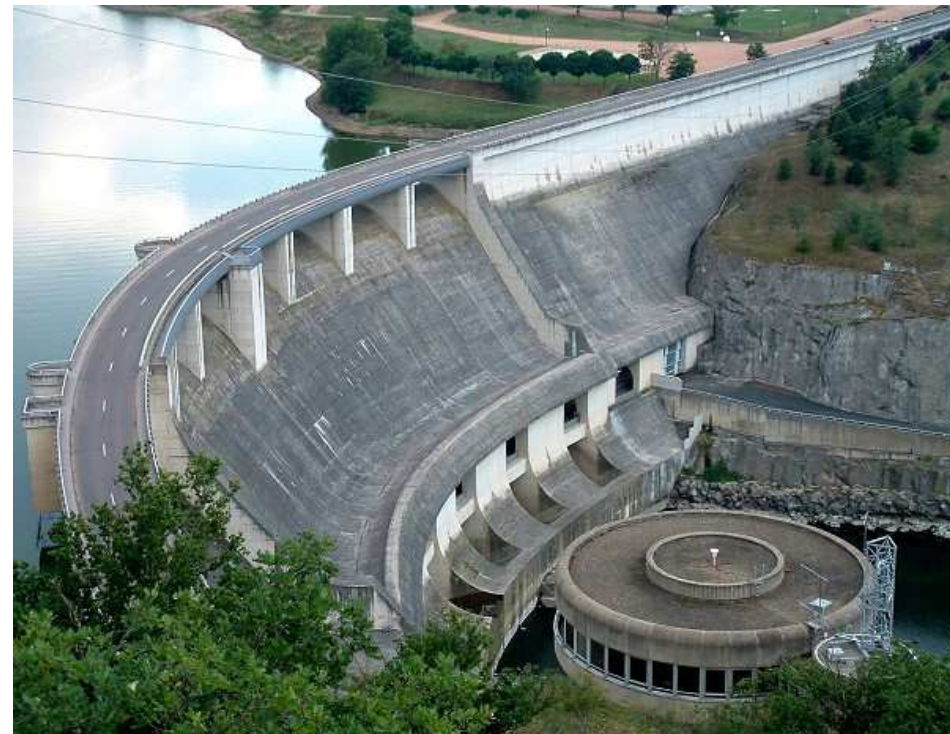
Barrage de Villerest
