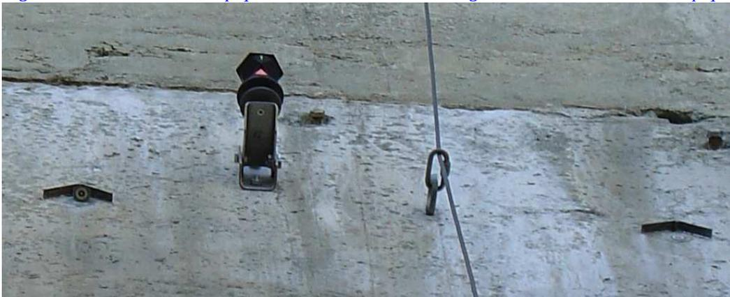
Figure 12 : Prisme 360°, cible (réseau+pendule optique), Alpiq
