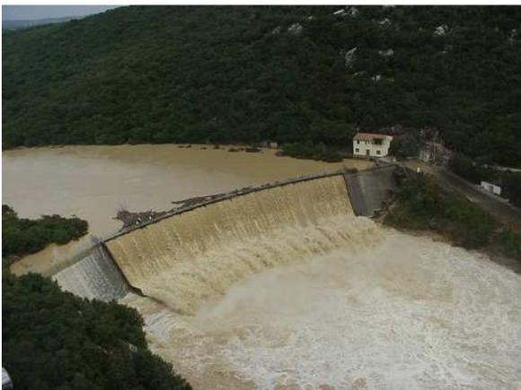
Figure 6 : barrage de la Rouvière pendant la submersion de septembre 2002, Bressand [2002]
