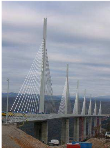
Figure 17 : Déformée de l'ouvrage pendant les essais
