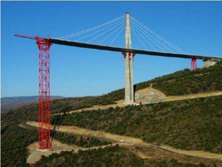
Figure 4 : Lançage du tablier côté nord
