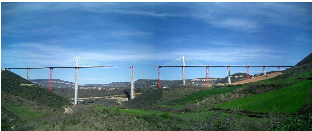
Figure 22: Le viaduc de Millau après le lancement L6
