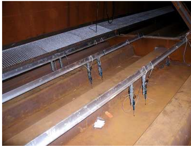
Figure 11 : Capteurs de "patch loading"
