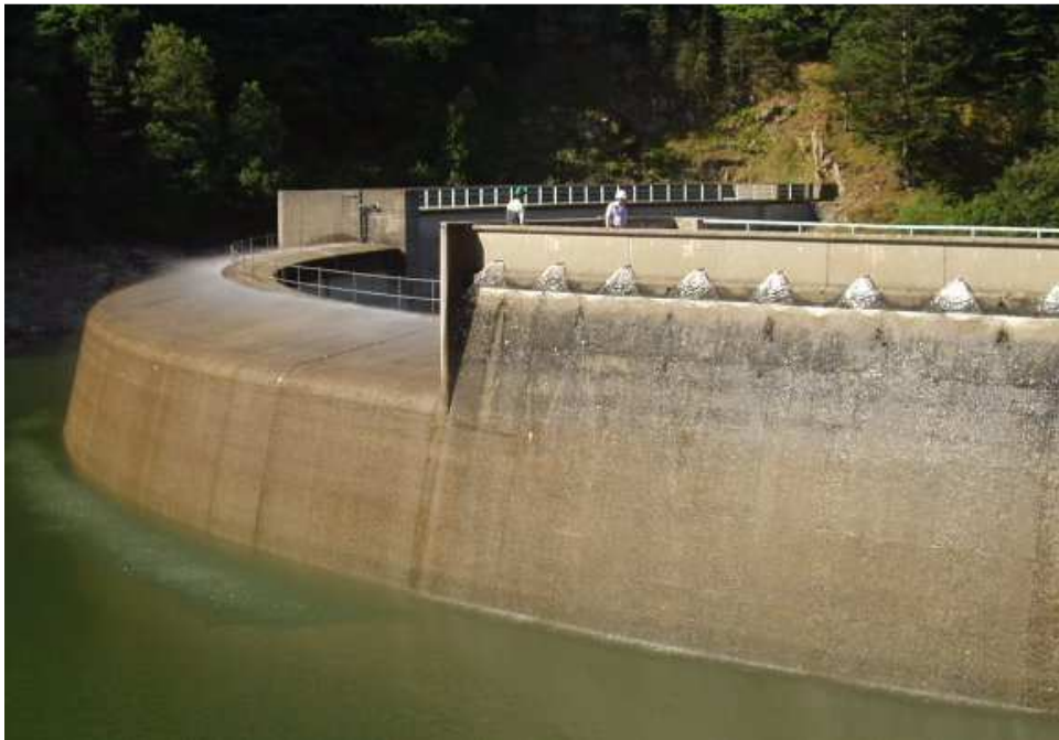
Figure 12 - Gage - Refroidissement par aspersion de la crête en été . (Photo Elisabeth Vergez)
