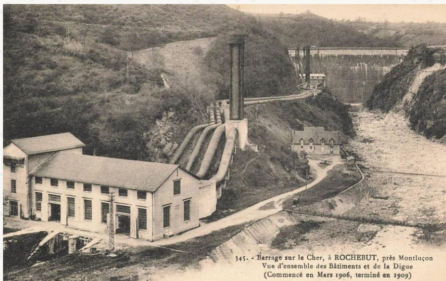
344 Vue générale du Barrage sur le Cher à ROCHEBUT, près de Montluçon pouvant contenir 30 millions de mètres cubes ; hauteur 45 mètres ; longueur 100 mètres ; 13 mètres d'épaisseur à la base et 5 mètres au sommet. Commencé en Mars 1906 ; terminé en 1909
