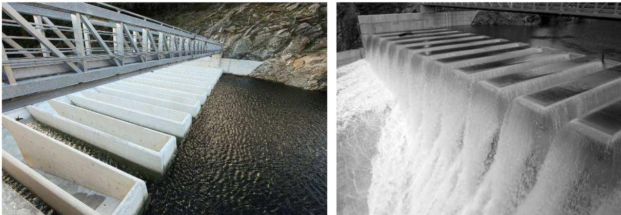
Figure 6,7 : PKW en cours de mise en eau (gauche) et en cours de déversement à 50 m<sup>3</sup>/s (droite)
