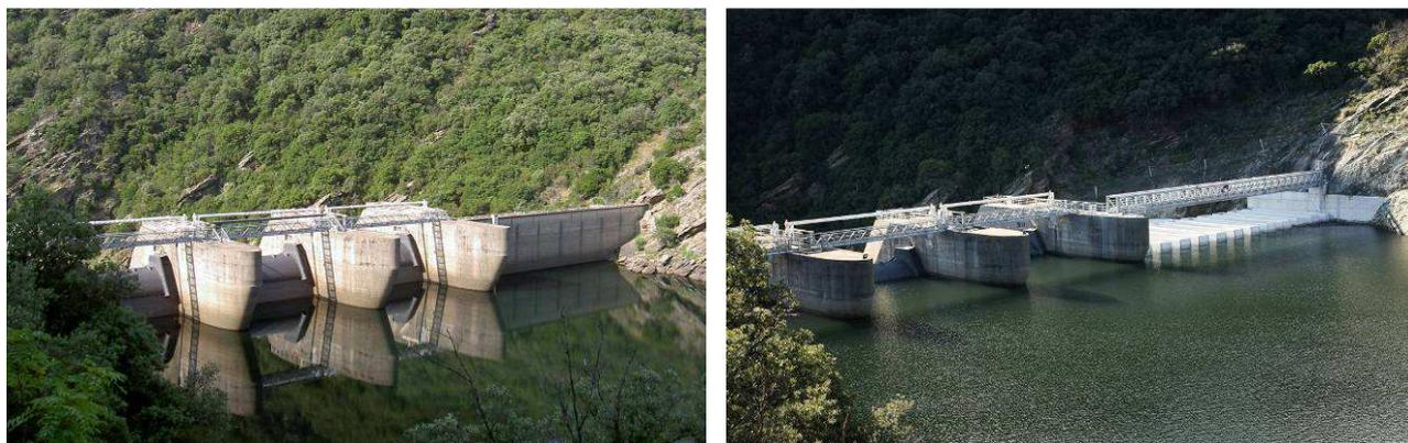
*Figure 1 : Photographie du barrage de Malarce vu d'amont rive gauche avant et après la réalisation du nouvel évacuateur de crues PKW.*
