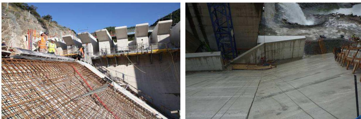
*Figure 4,5 : Coursier en cours de construction (gauche) et ouvrages de dissipation d'énergie (droite)*
