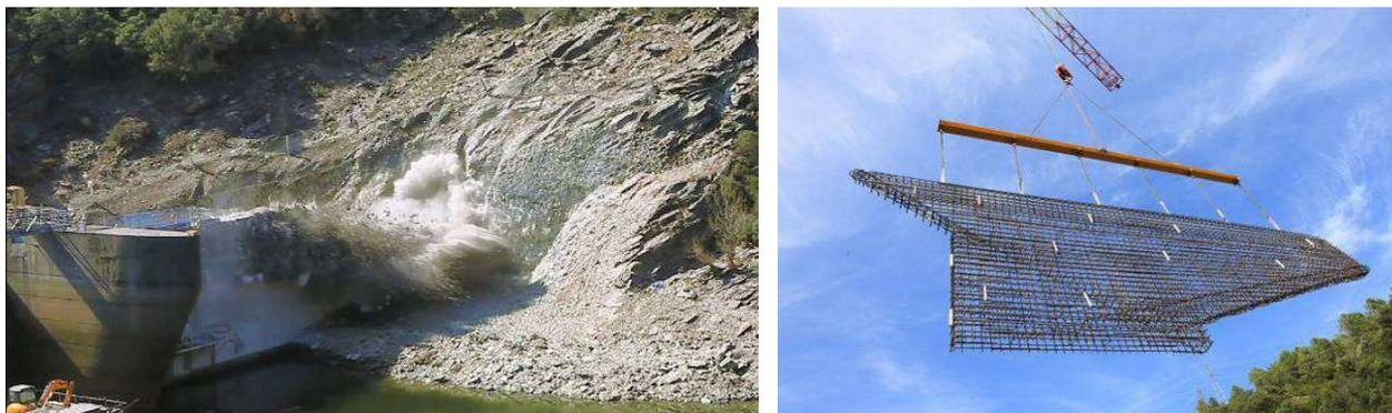
*Figure 2,3 : Culée rive droite en cours de démolition (gauche) et cage d'armatures préfabriquée sur site pour un voile (droite)*
