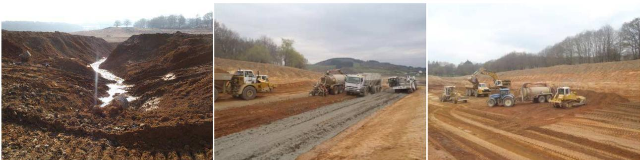
Figure 4. De gauche à droite : fossé de drainage ; traitement ; chargement du matériau traité.
