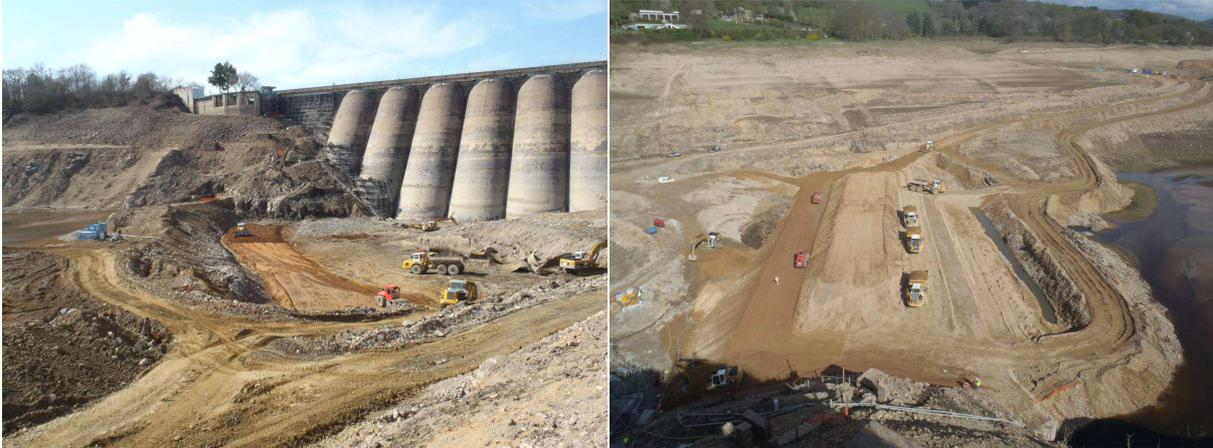
Figure 5. A gauche : 1<sup>ère</sup> couche de remblais ; à droite : remblais du premier tiers inférieur du batardeau
