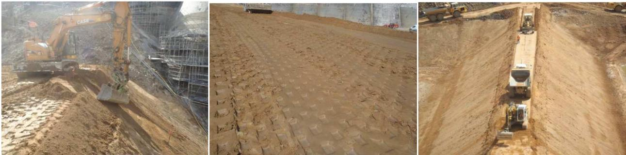
Figure 6. De gauche à droite : reprofilage du talus ; empreinte du pied d'âne ; dernières couches de remblai
