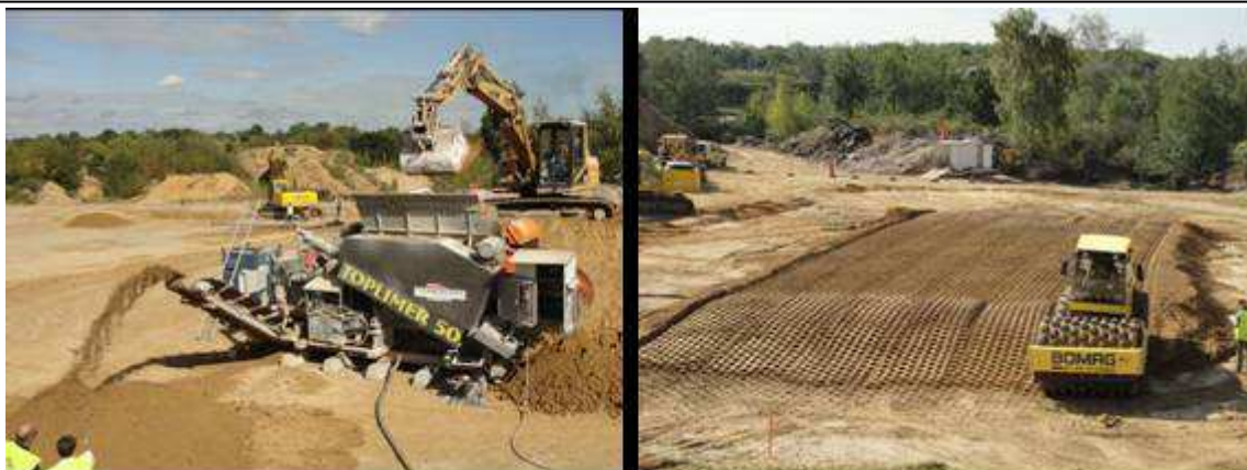
Production du matériau traité en centrale mobile et compactage par pétrissage (pieds dameurs)
