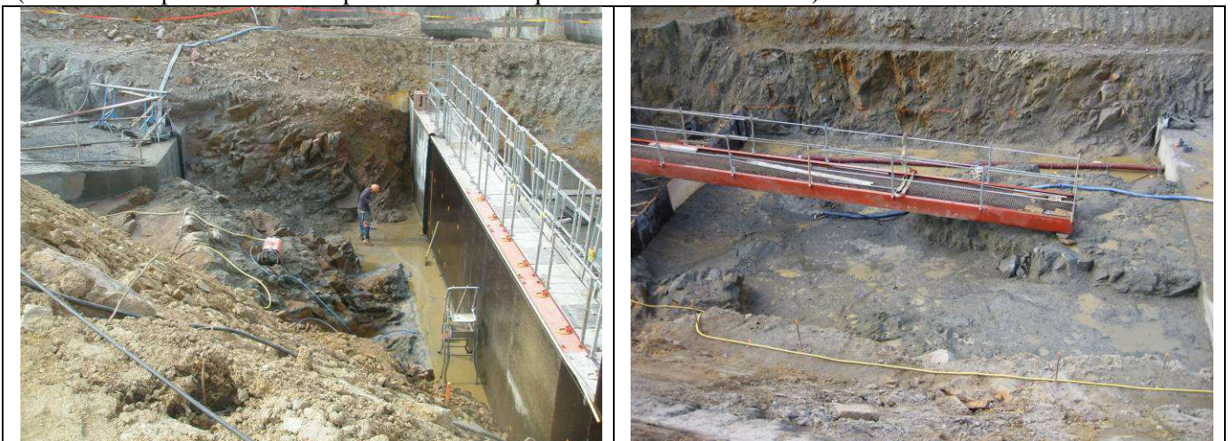
Figure 1 : Vues du fond de fouille
