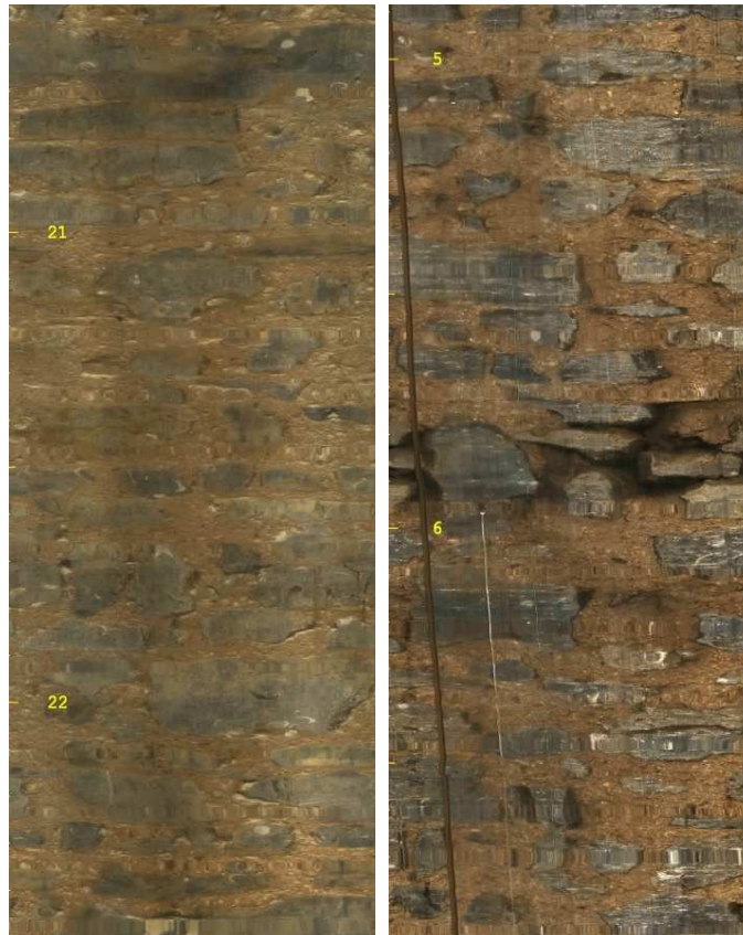
Graphique 2 : Résultats d'imagerie optique : à gauche maçonnerie en bon état, à droite maçonnerie avec vides (barrage de Chazilly)
