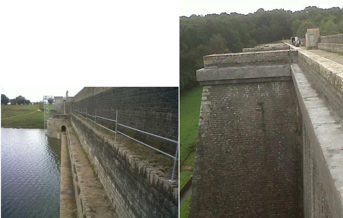
*Photos 1 et 2 : Parements amont et aval du barrage de Chazilly*
