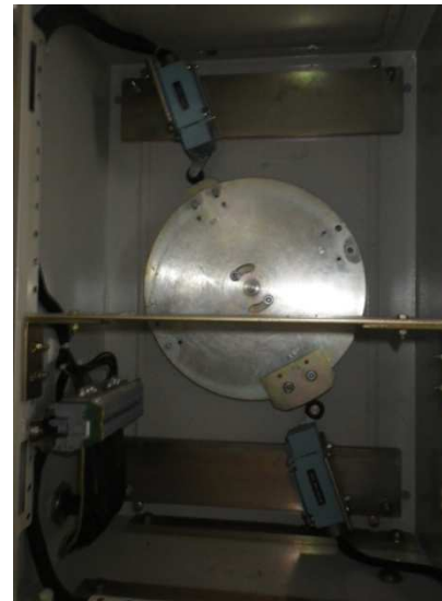
Dispositif de crantage (Barrage de Jons)
