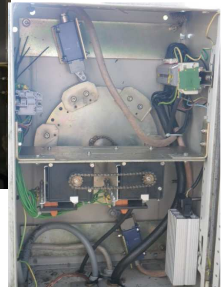
Dispositif de crantage et codeur GRAY (Barrage de Jonage)
